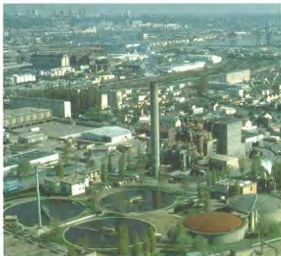
Station d'épuration des eaux à Rouen.
