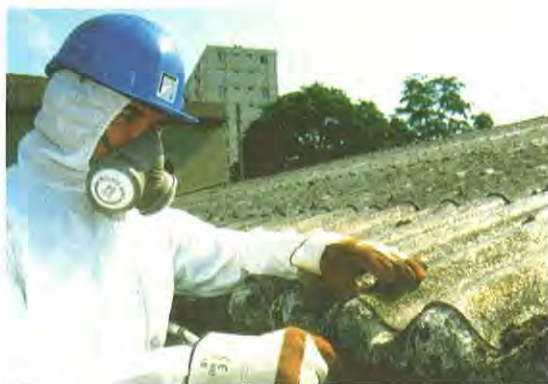
Chantier de désamiantage
