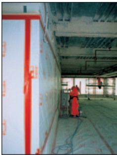
© INRS Chantier de désamiantage
