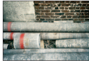
Crédits : INRS Canalisation en amiante ciment
