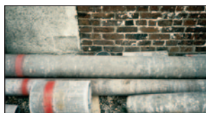
© INRS Canalisation en amiante ciment
