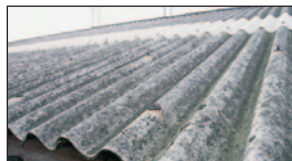
© INRS Toiture en amiante ciment
