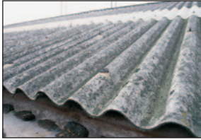
Crédits : INRS Toiture en amiante ciment
