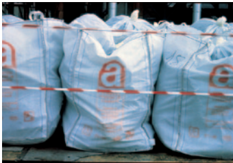
© INRS Déchets amiantés
