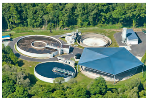
Station d'épuration. © Laurent Mignaux.
