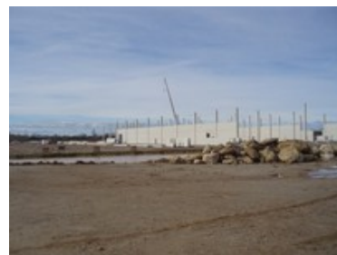
Bouches du Rhône, Saint-Martin de Crau – Aménagement d'une plateforme logistique
